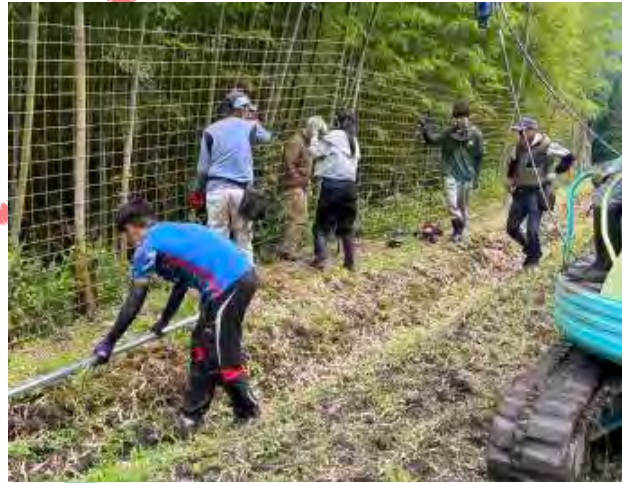
獣害対策用フェンスの設置
